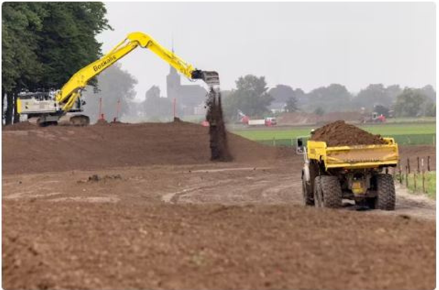
Grond waarmee in de uiterwaarden nevengeulen en natuurgebieden zijn gegraven, verwerkt Boskalis tegen de dijken verderop. Foto: Sjef Prints/ APA
