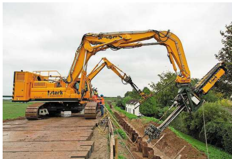
Verankerung dijkversterking Vianen
