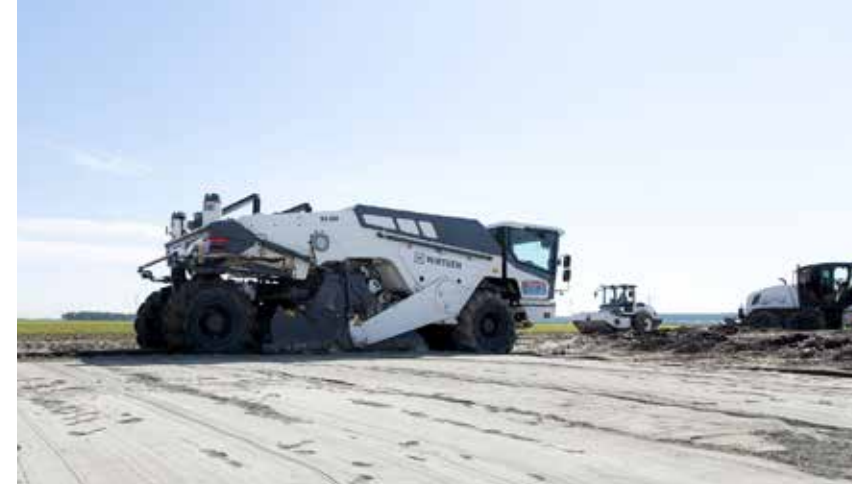
Nadat de muren zijn gerealiseerd wordt de Enviro-Mat aangebracht. Dit gebeurt met gebiedseigen grond.
