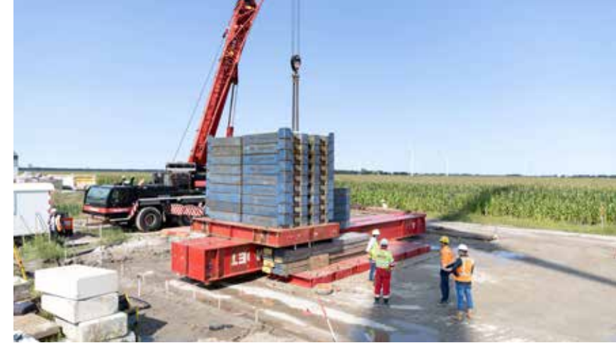
Met de muren en de mat gereed, wordt vervolgens de proefopstelling geplaatst om een belastingsproef te doen.
