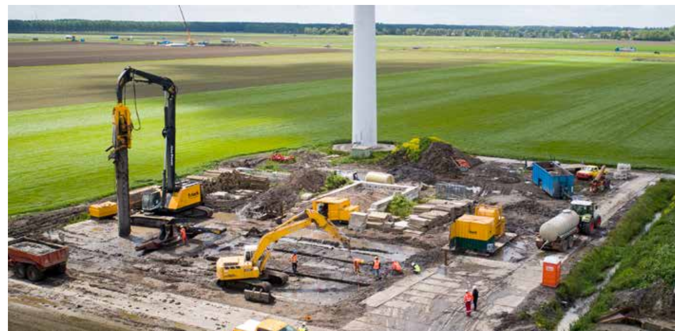
De testlocatie in Zeewolde waar de Enviro Wall-Mat techniek in de praktijk is getest. Links het prototype van de E-wall machine.
