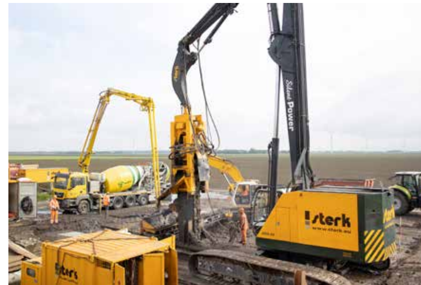
De grond wordt volledig weggefreed en de ontstane sleuf wordt direct en gecontroleerd gevuld.
