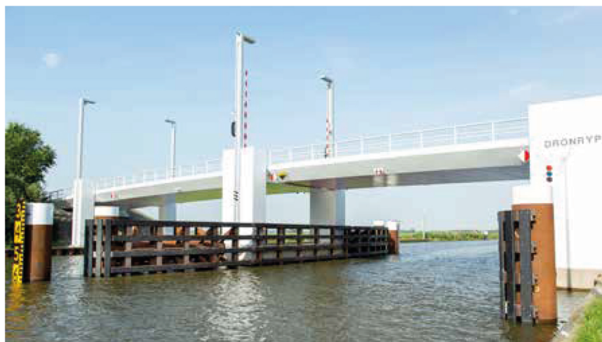
Voor de nieuwe brug bij Dronryp ontwierp, maakte en plaatste Sterk al het remmingwerk.
