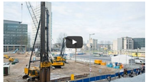
Damwand drukken en voorbereiden Parkeergarage Jaarbeursplein Utrecht
