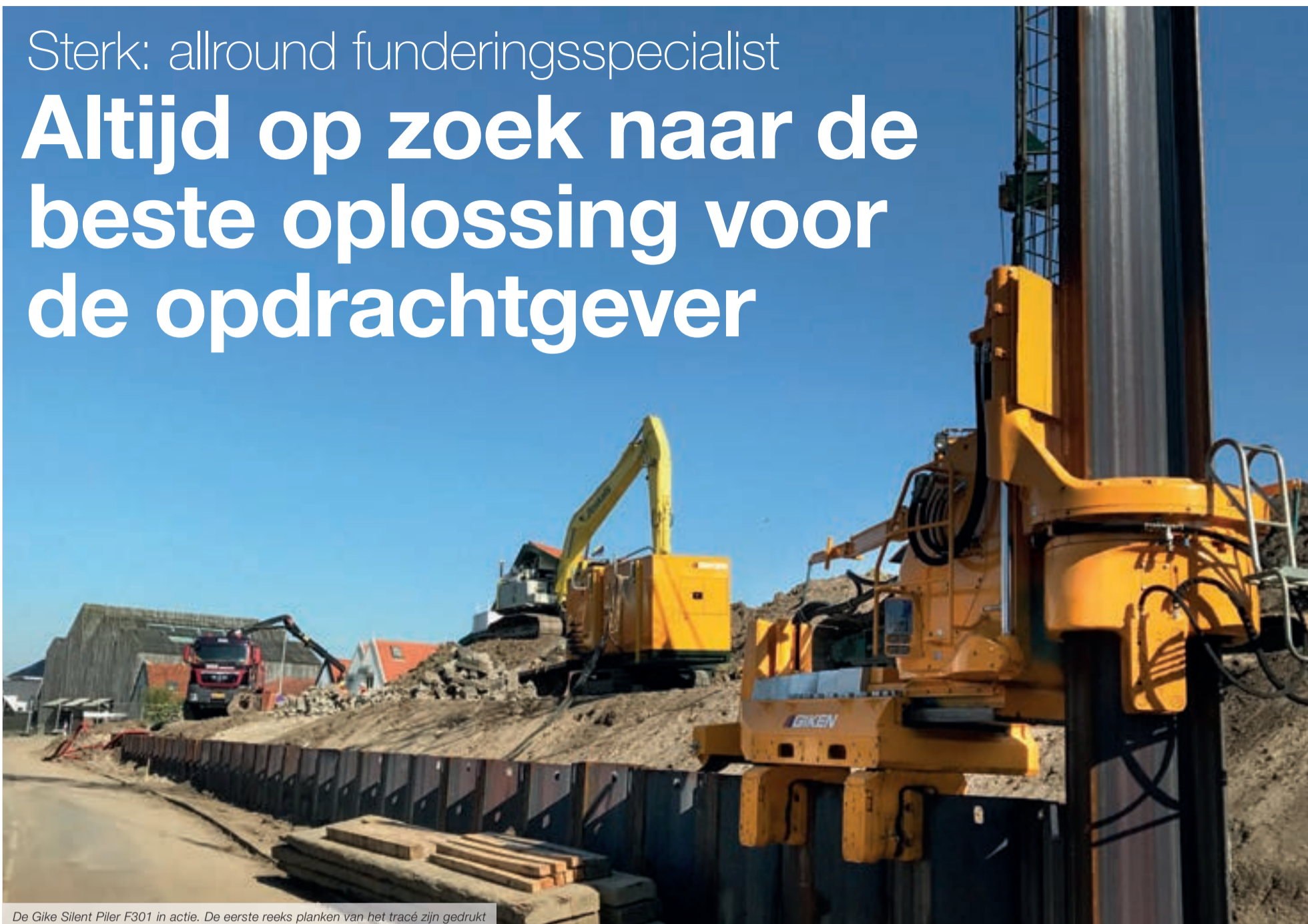
De Giken Silent Piler F301 in actie. De eerste reeks planken van het tracé zijn gedrukt
