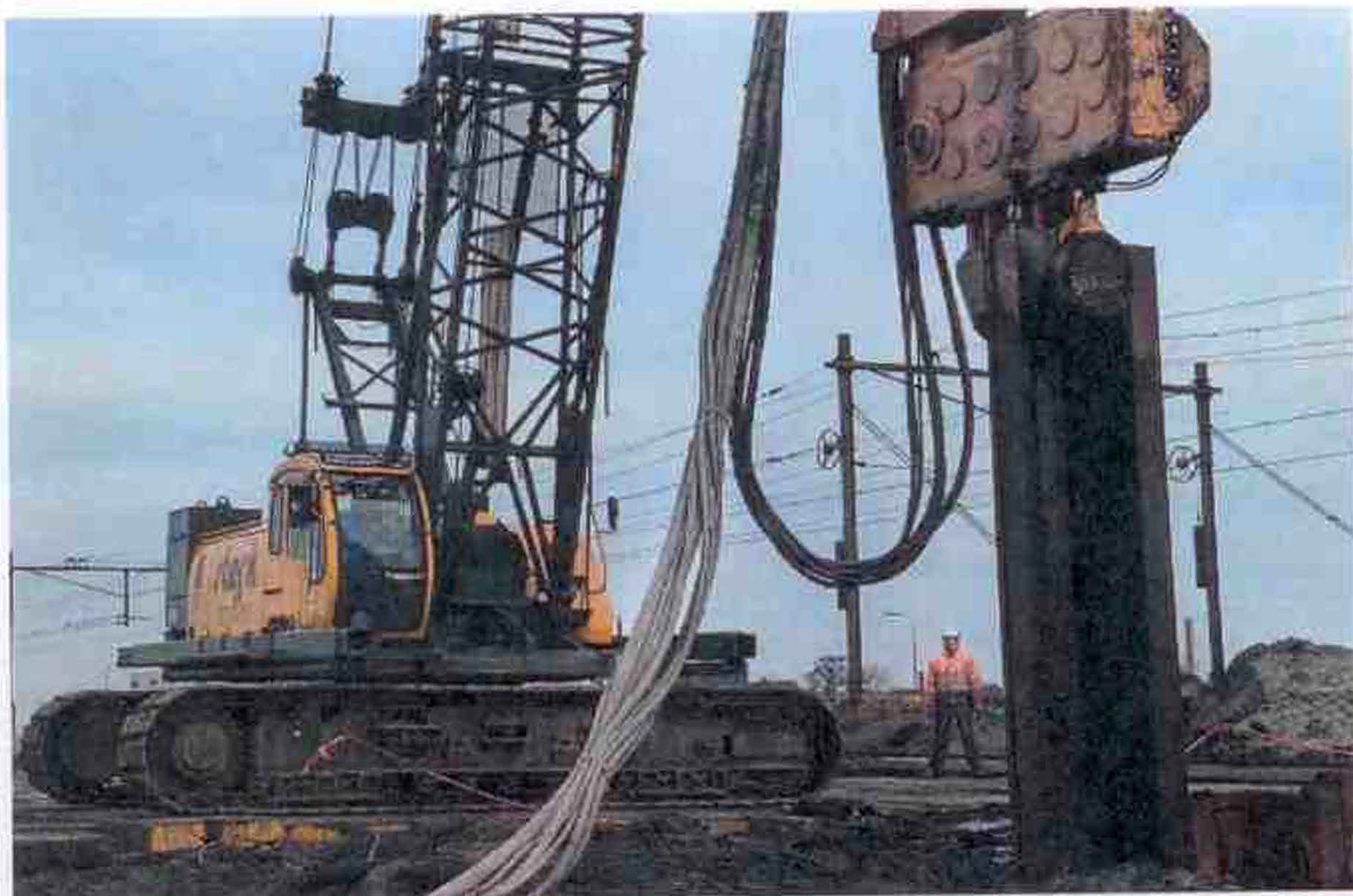
Sterk Heiwerken uit Drachten haalt 54 damwanden uit de grond bij Wirdum.
