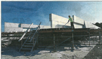
■ Het spoordek staat nu nog op stutten. Om het naar zijn plek te kunnen brengen, wordt het op een mobiel onderstel met heel veel wielen gezet.
