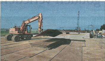
■ Ter voorbereiding worden rijplaten gelegd waarover het spoordek in de nacht van zaterdag op zondag naar zijn plek wordt gereden.
