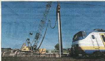
■ Het trillen van damplaten en pijlers gaat gepaard met een hoop lawaai. Het wordt daarom zoveel mogelijk overdag gedaan.
