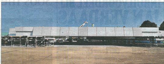
■ Het spoordek is 35 meter lang, 11,5 meter breed en varieert in hoogte tussen de 2 en 3 meter. Het betonnen kunstwerk weegt duizend ton oftewel één miljoen kilogram. foto's Robert van den Berge/het fotoburo
