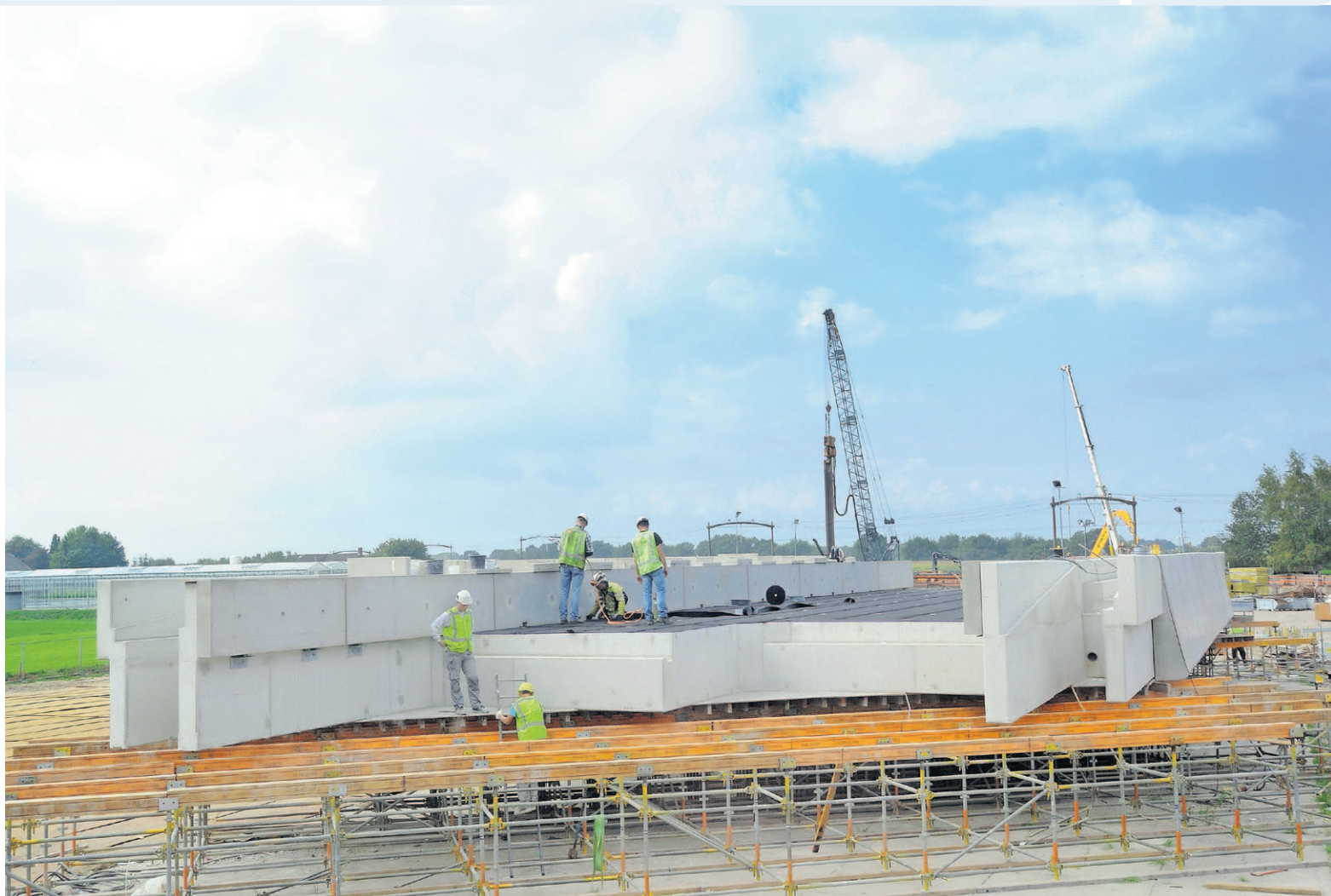
Het prefab spoordek van de onderdoorgang wordt gereed gemaakt voor transport. Foto: Erald van der Aa
