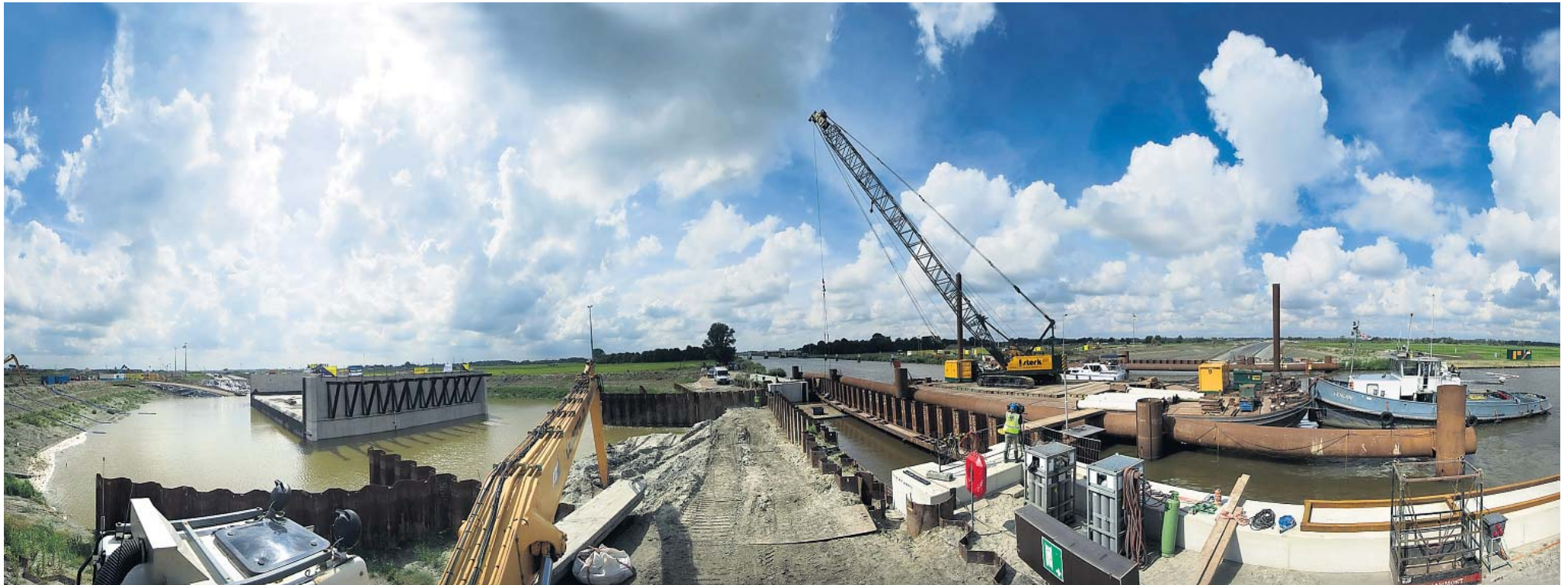
Links drijft de tunnelbak in de zuidelijke bouwkuip.
